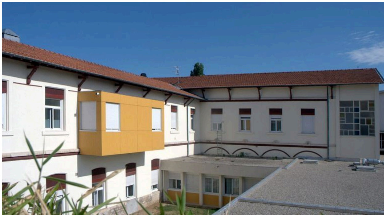
Façade postérieure (est)
