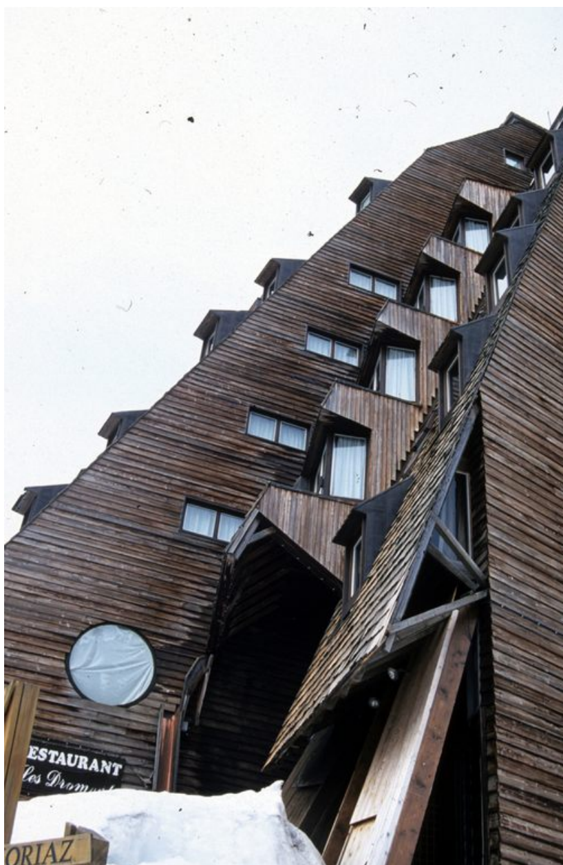
Détail de la façade sud, vue depuis l'est
