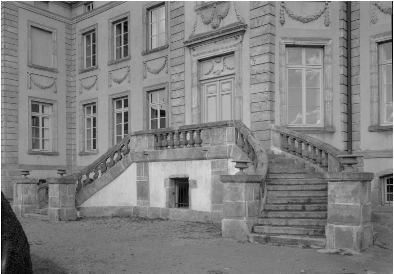
Détail de la façade sur jardin : l'escalier en fer à cheval vu du sud-ouest.
