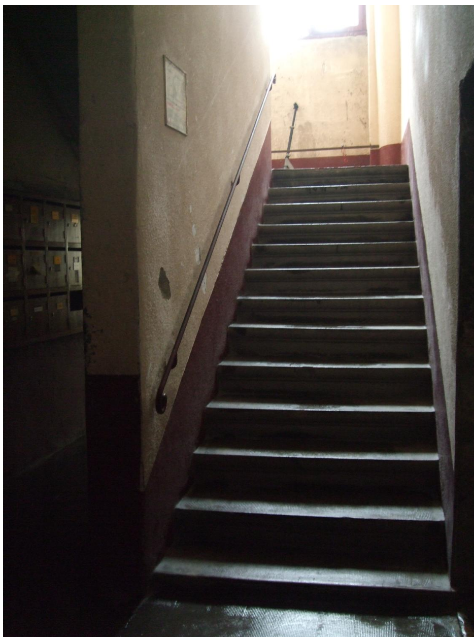
Escaliers à mur noyau plein
