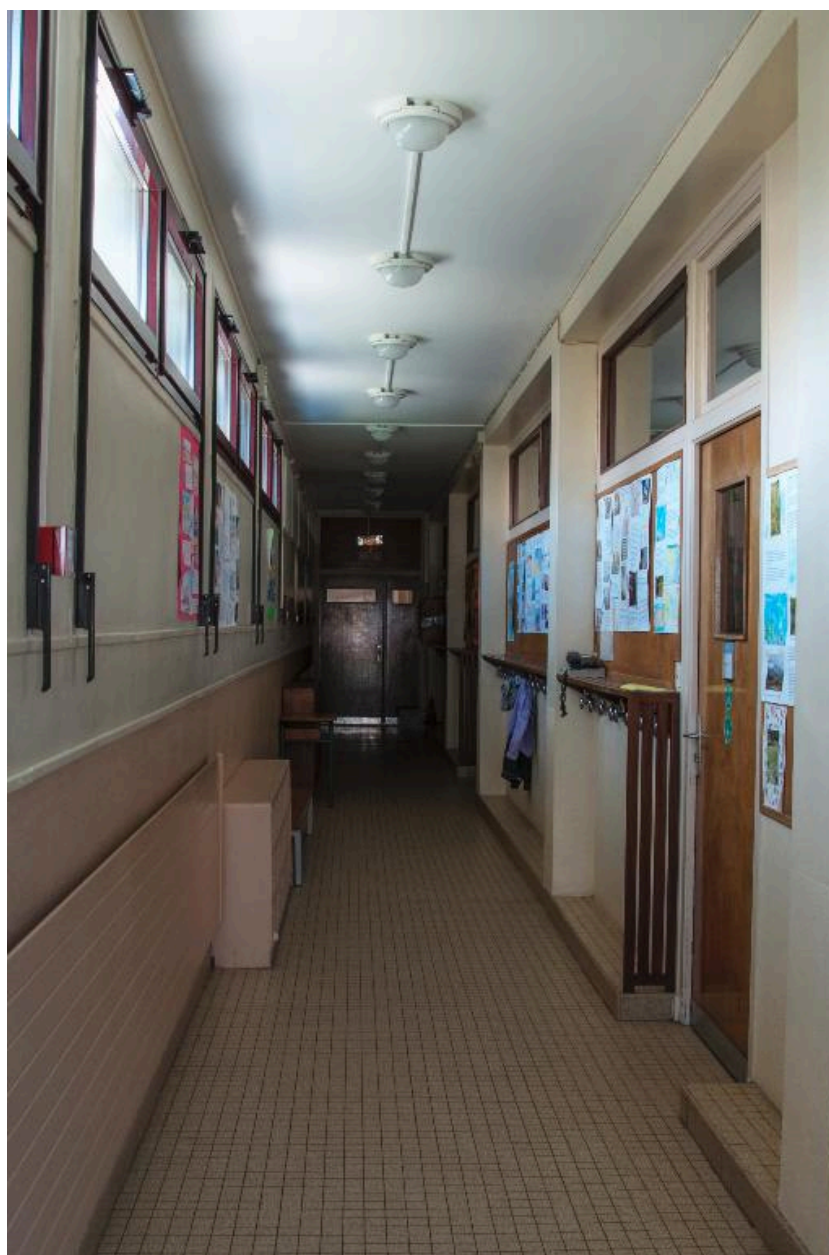
Couloir de distribution, rez-de-chaussée
