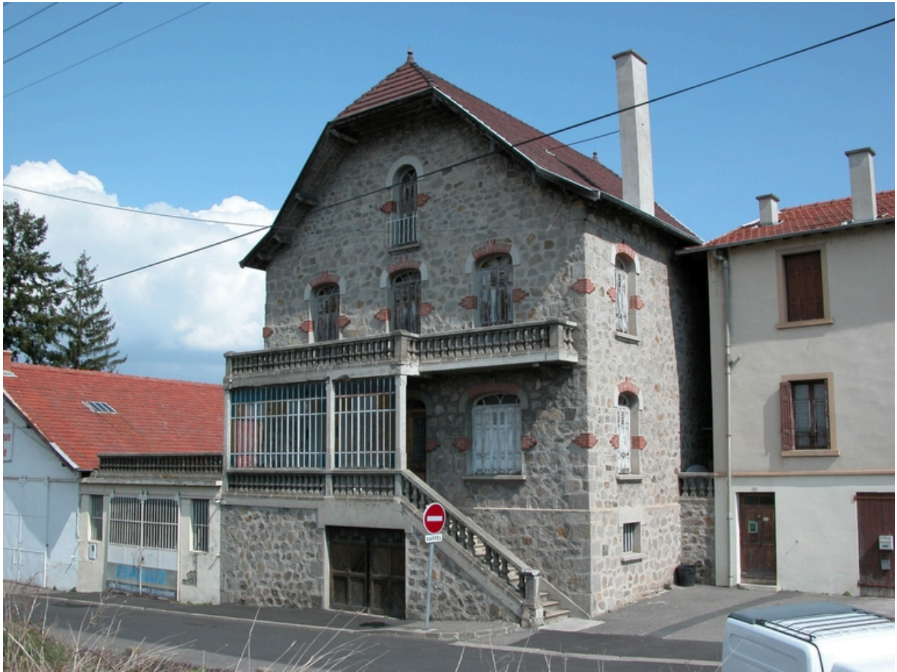
Quartier de Pleuvev, rue de la Petite Vitesse. Maison, remise, atelier ou usine (1809 C 12 a).
