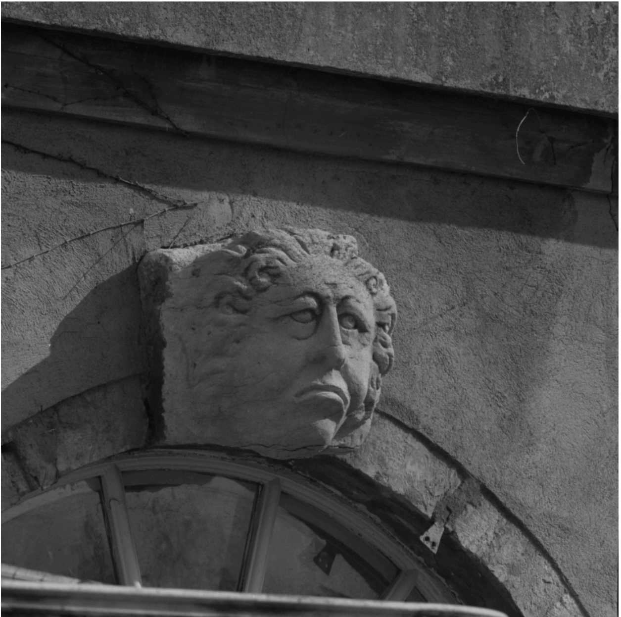
Façade sur jardin, détail : baie latérale droite travée axiale, agrafe figurée, vue de 3/4 gauche.
