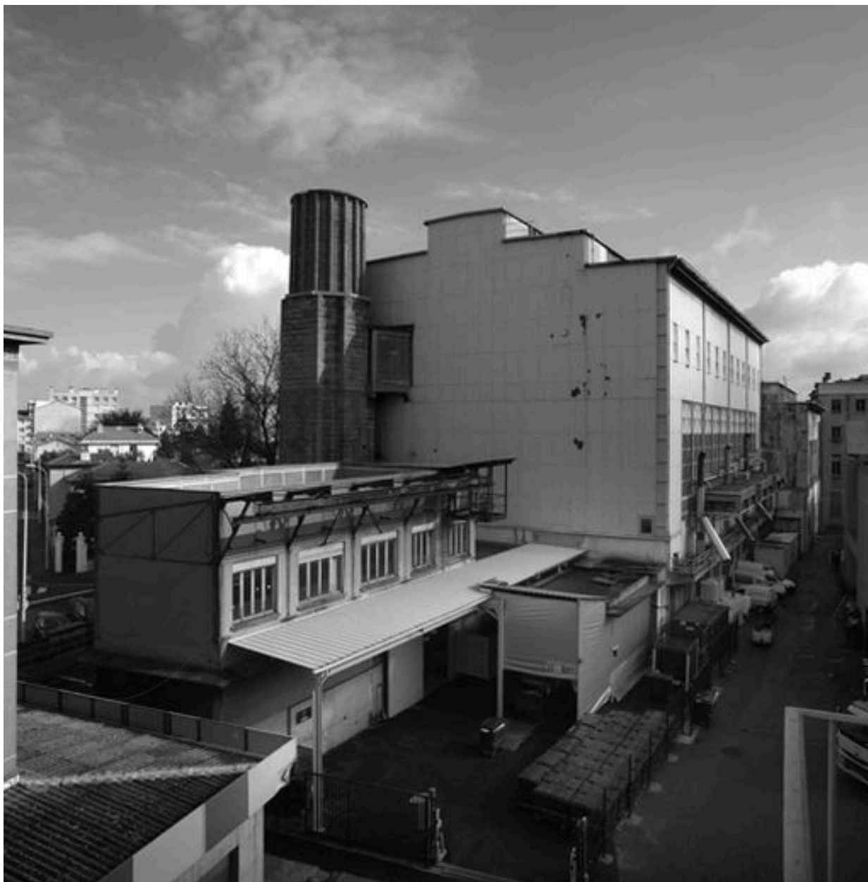
Vue générale depuis le sud-ouest
