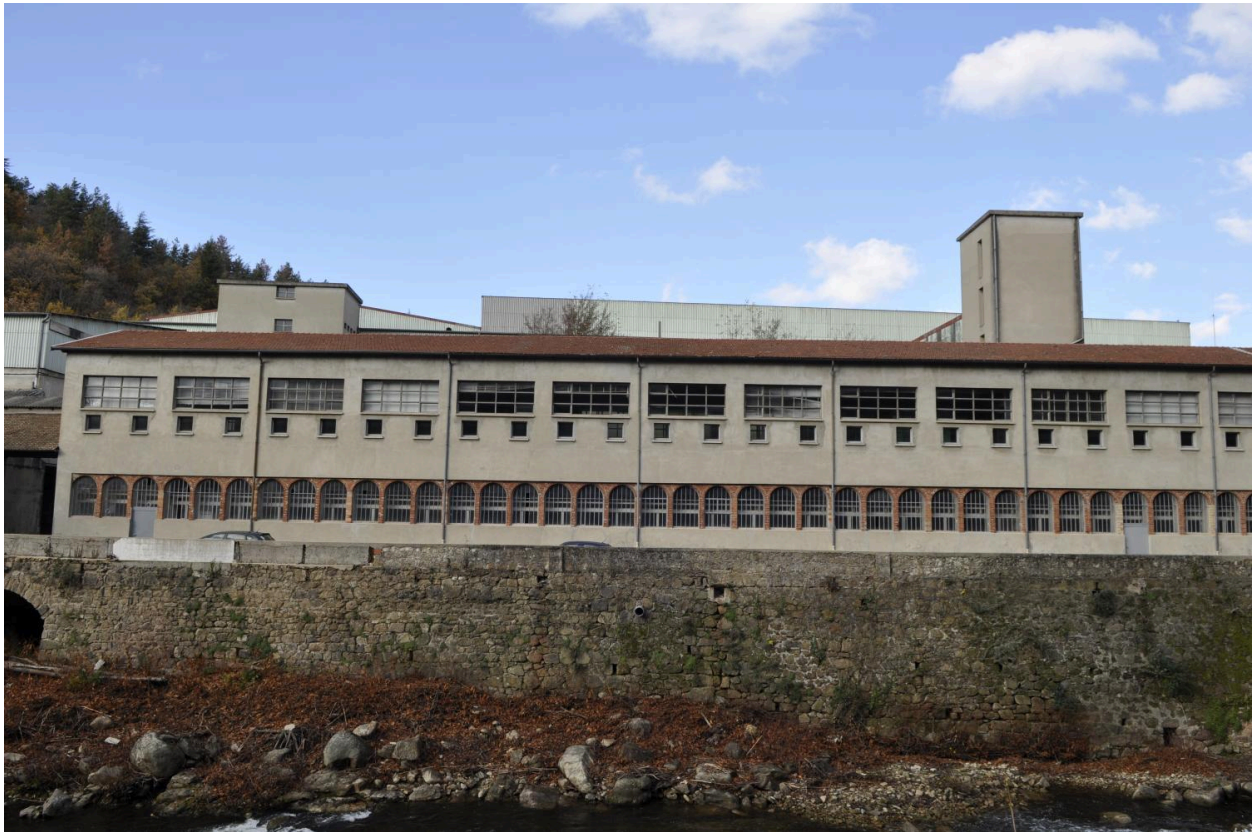
Détail façade du bâtiment de la machine à papier
