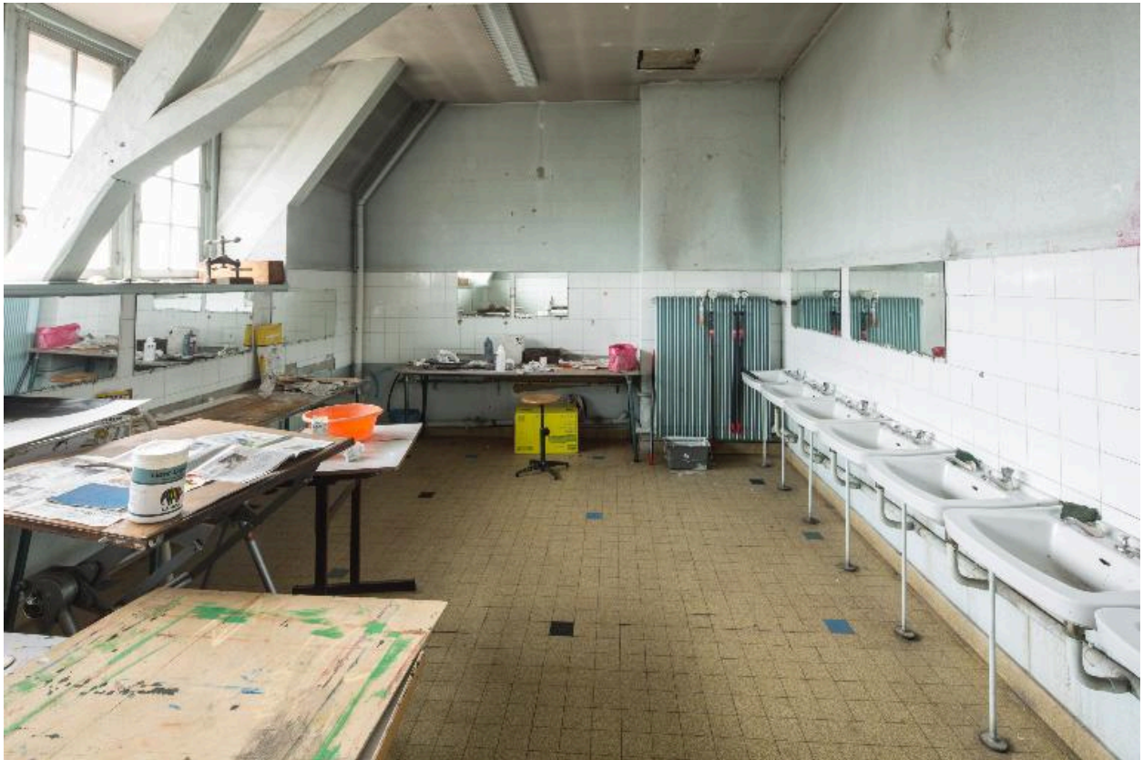
Bâtiment F. Combles. Salle de dessin
