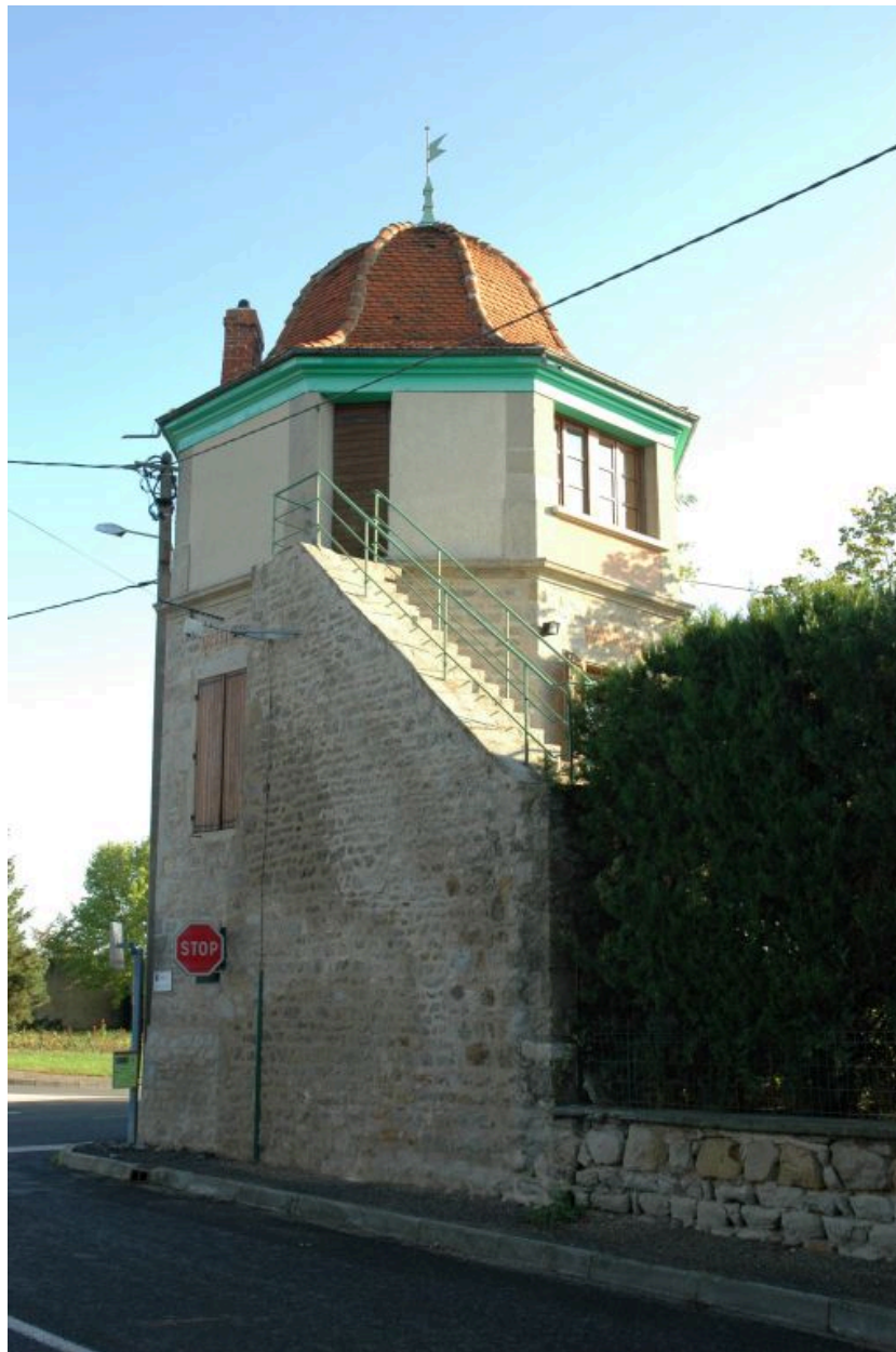
Rigaud, maison 1986 AB 1. Détail du pavillon d'angle
