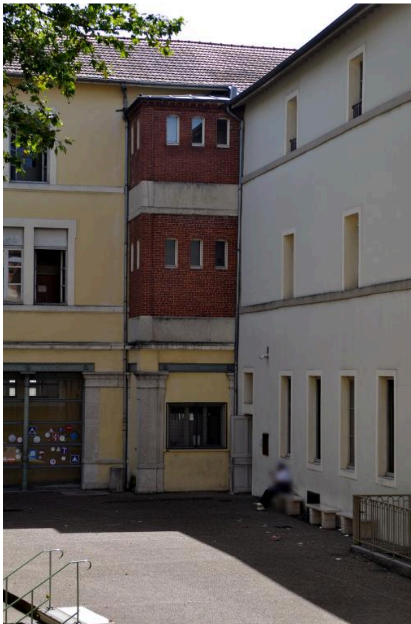
Cour 3 angle nord-est : ressaut comprenant la cage d'escalier
