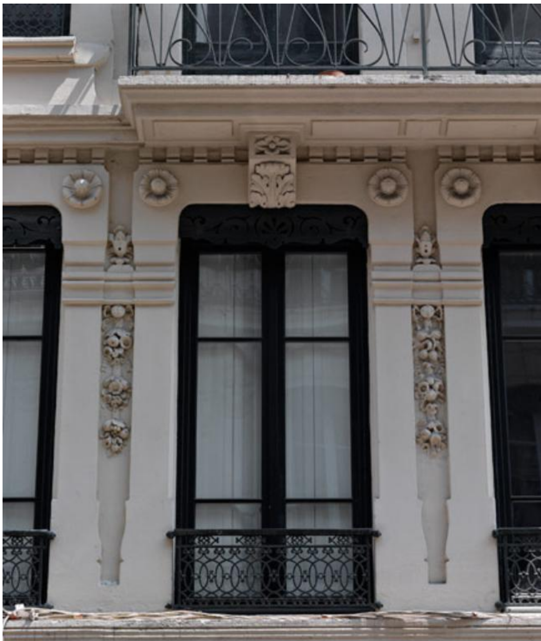
Elévation antérieure : détail de l'ornementation
