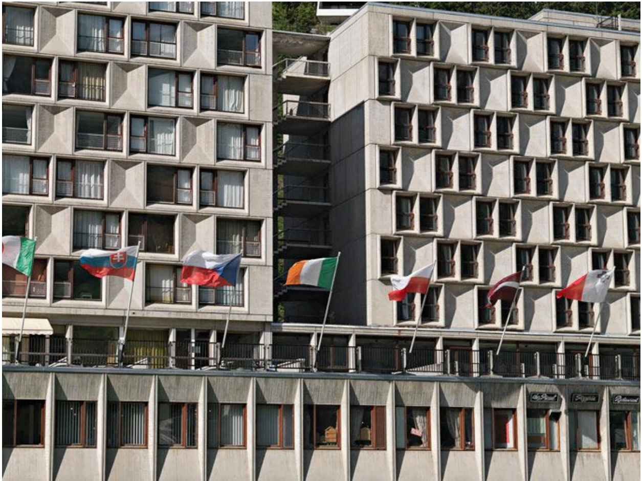
L'escalier entre la résidence Cassiopée et l'hôtel les Lindars ; détail des baies et des panneaux de ciment moulé de la façade principale
