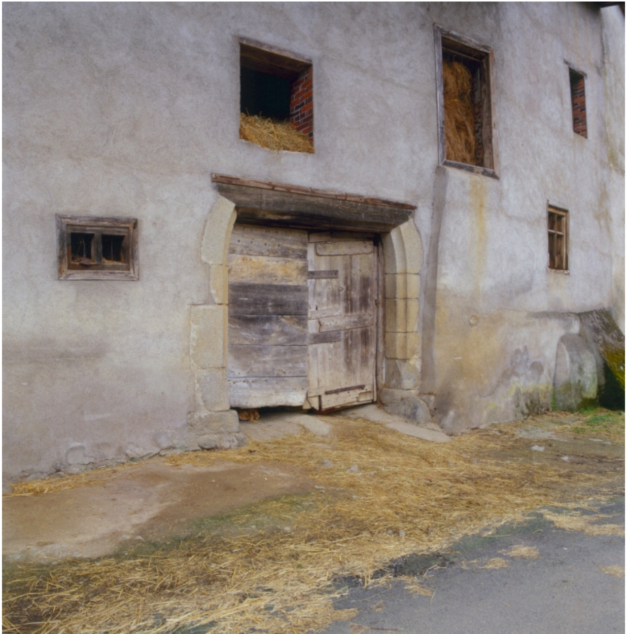
Détail de l'élévation principale : porte et ouvertures de la grange.
