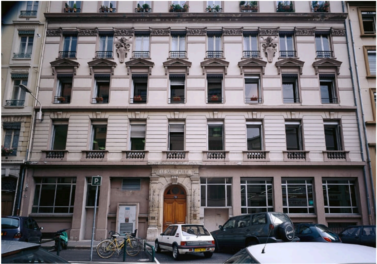
Vue d'ensemble ouest
