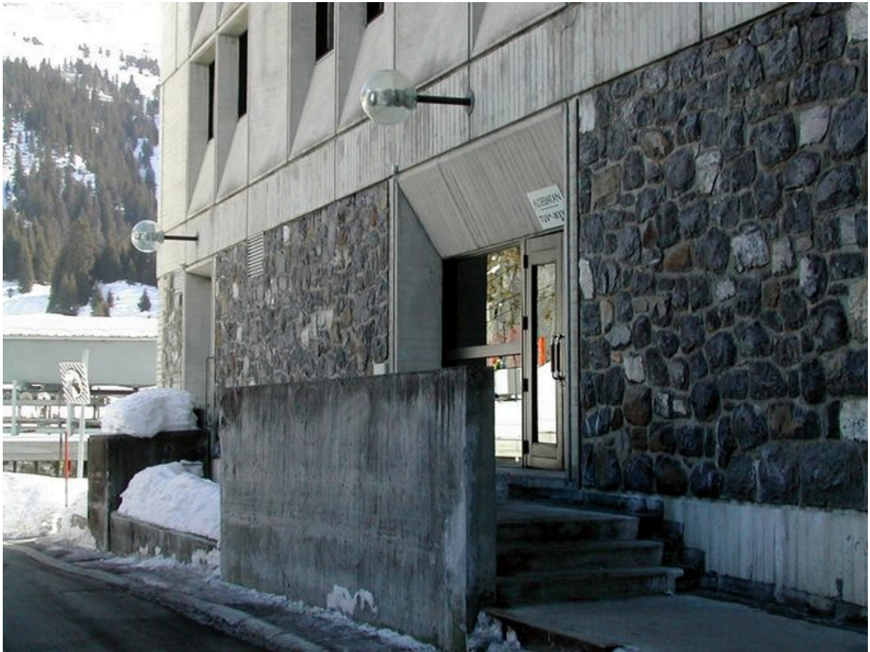
Entrée de l'immeuble sur l'élévation postérieure
