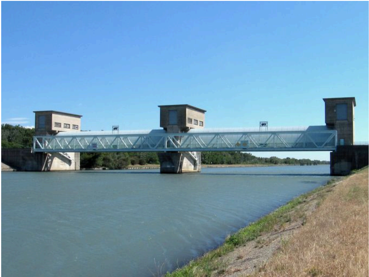
Barrage aval : vue générale, face amont
