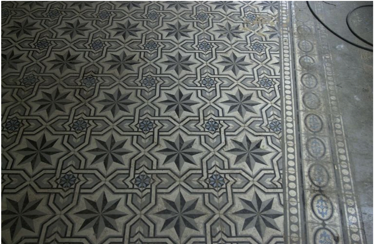
Boulangerie : détail du revêtement de sol en carreaux de ciment dans la boutique
