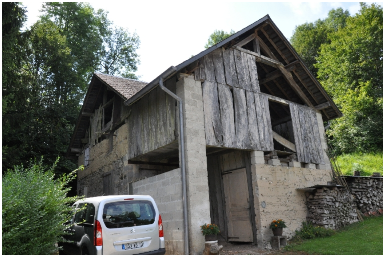
Vue de la façade nord-est
