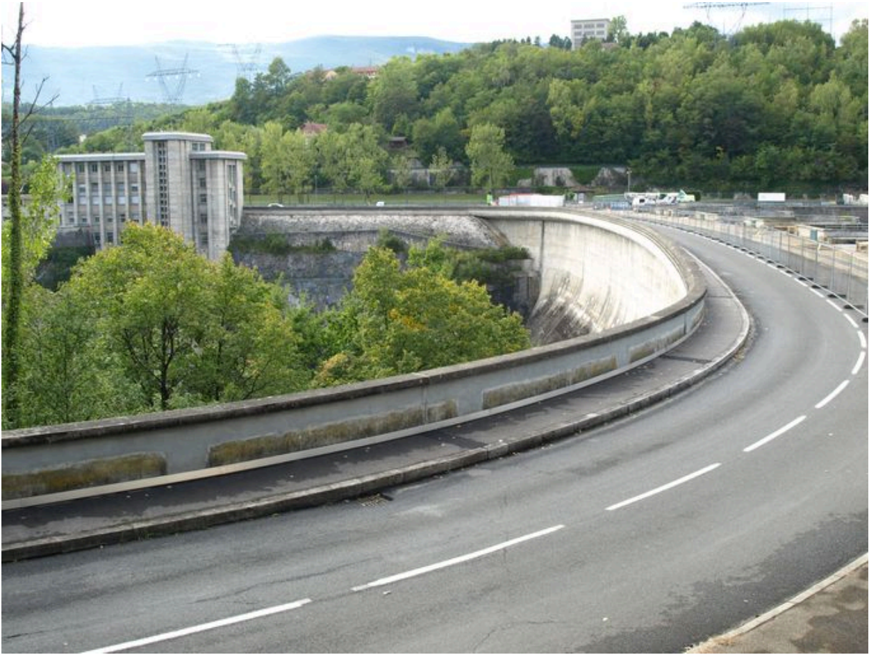
Vue de la chaussée du pont amont du barrage (depuis la rive gauche)
