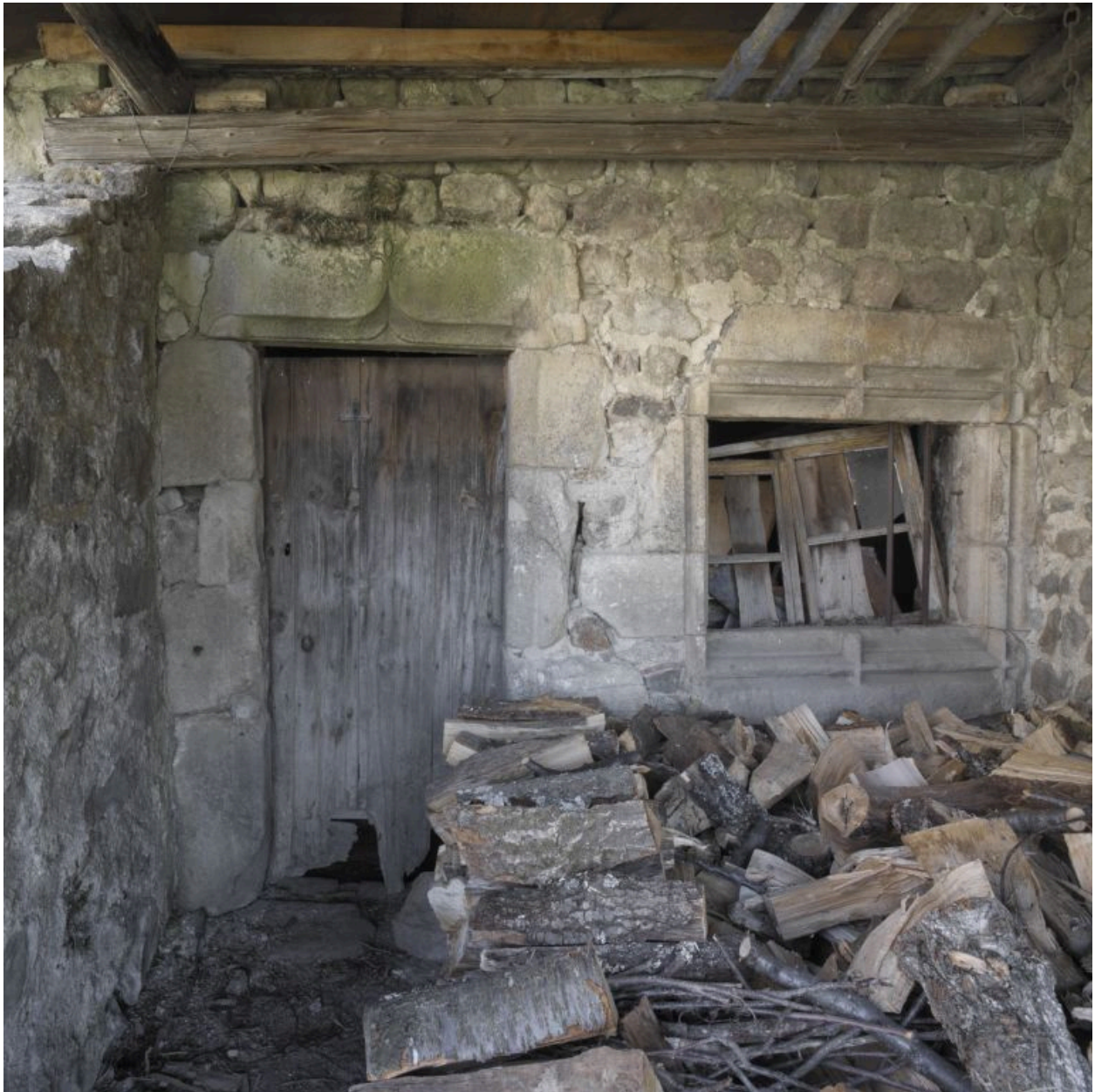
Détail de la façade sud du logis 4.
