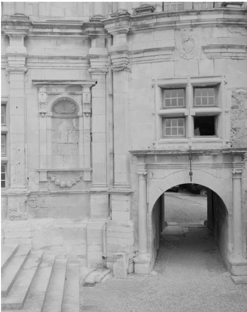
Bâtiment sud. Tour sud-est. Niche au rez-de-chaussée.
