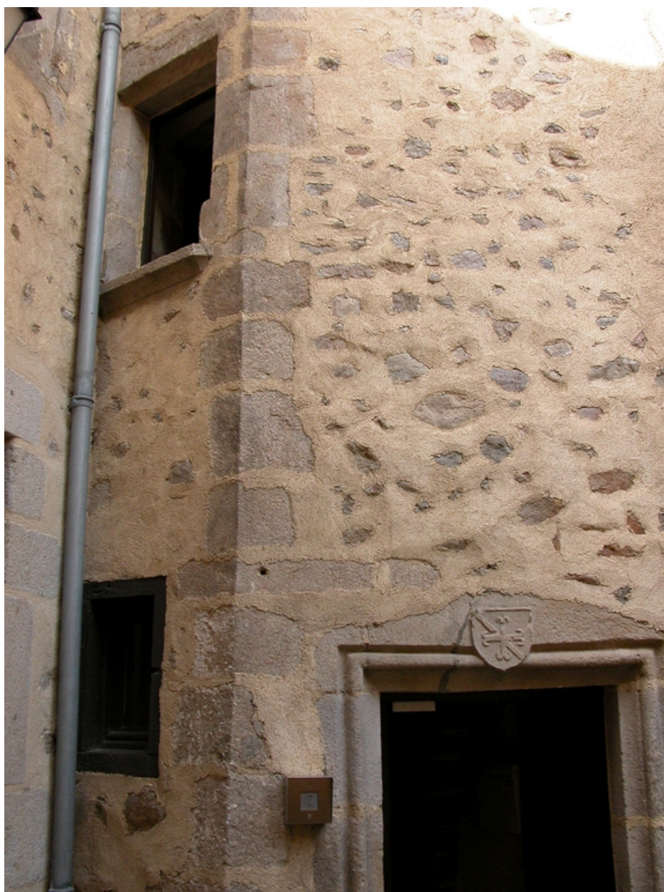
Vue intérieure de la cour : tour d'escalier, partie intermédiaire.
