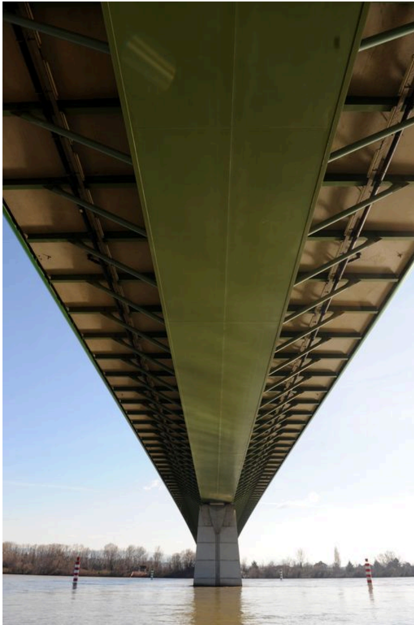
Vue partielle, de dessous, tablier et pile (depuis la rive droite)
