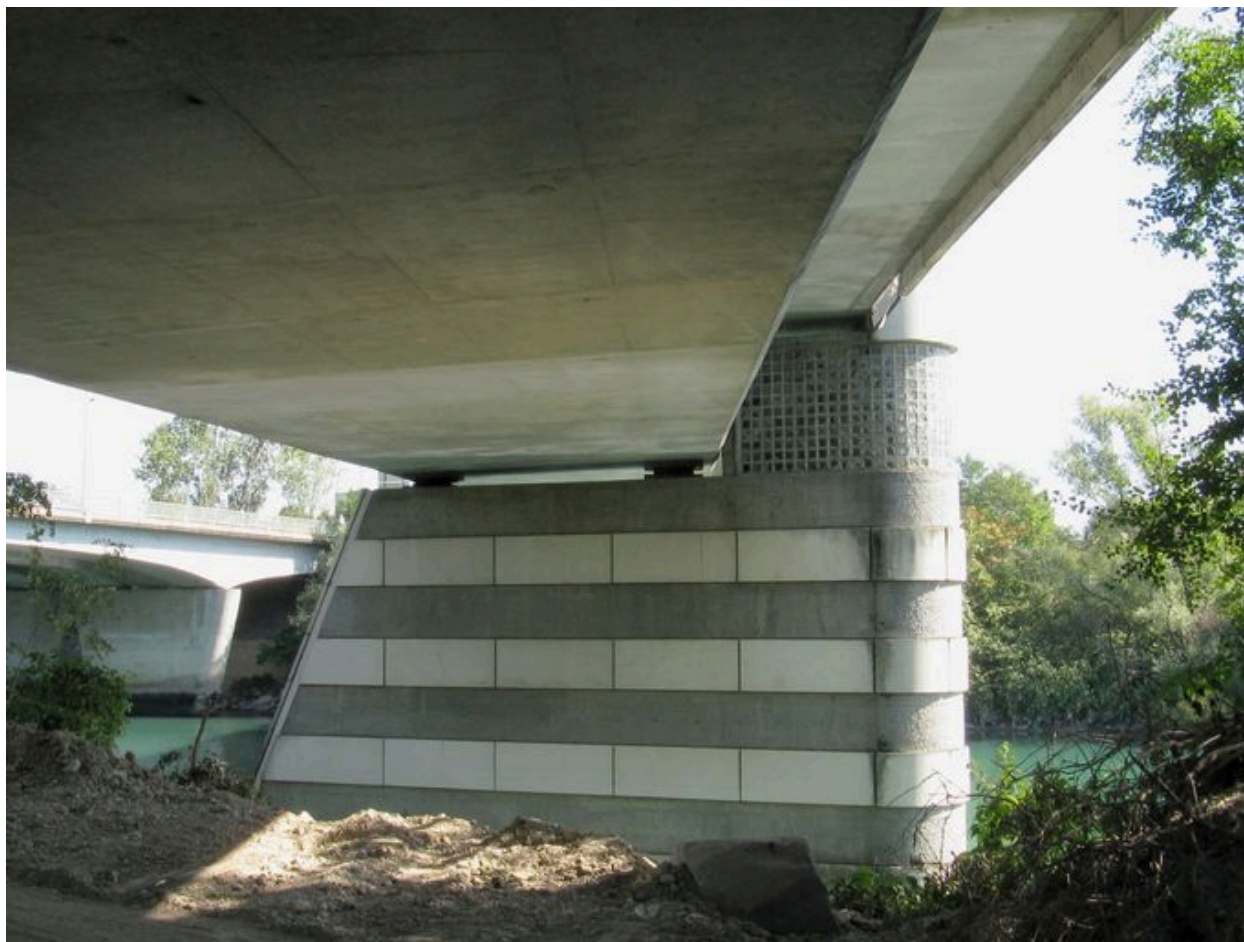
Tablier vu de dessous et pile (depuis la rive gauche)
