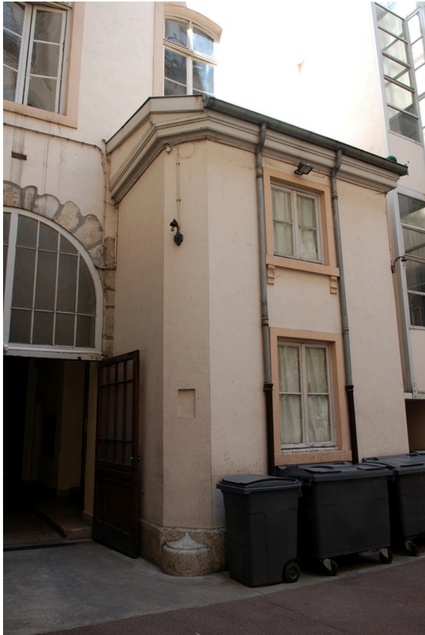
La cour : élévation ouest, loge de concierge
