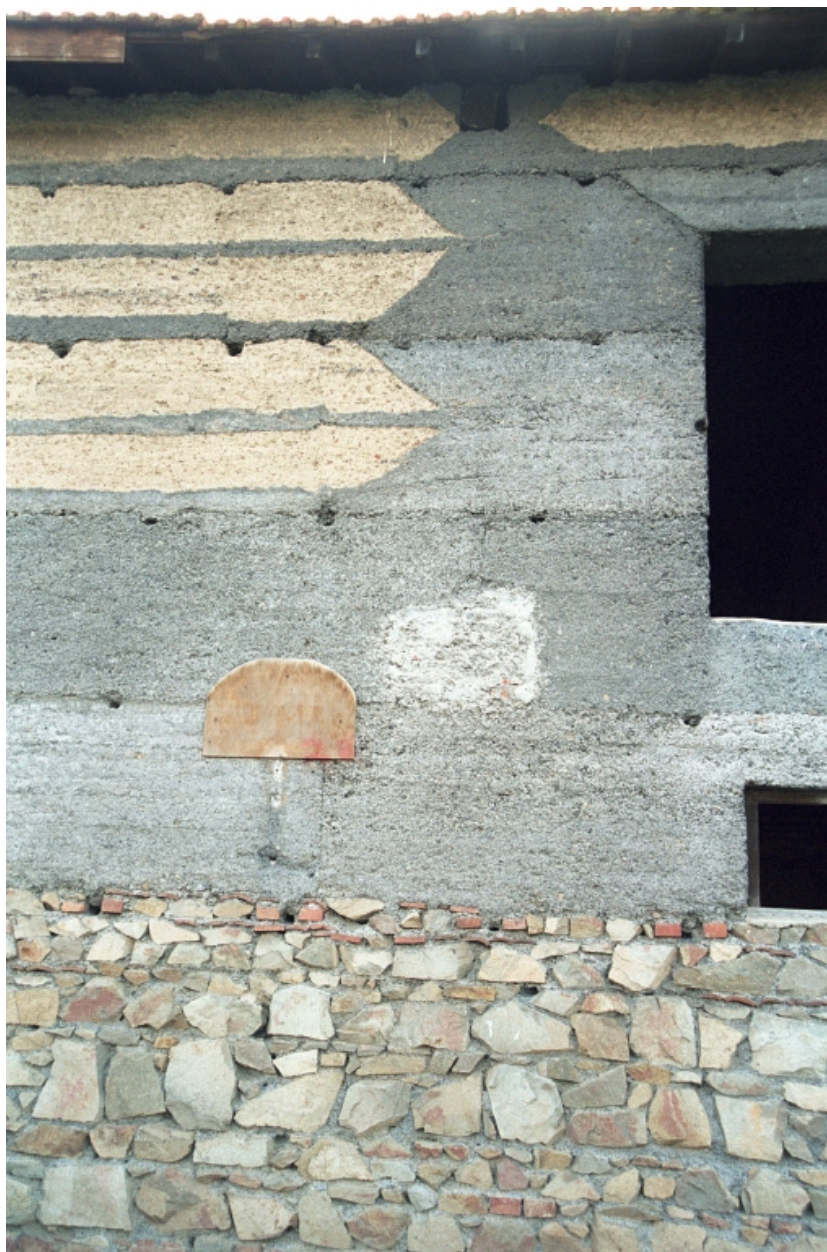
Boën, la Chaux-est, ferme (1986 AE 294).Grange-étable, détail du pisé de mâchefer (milieu 20e siècle).
