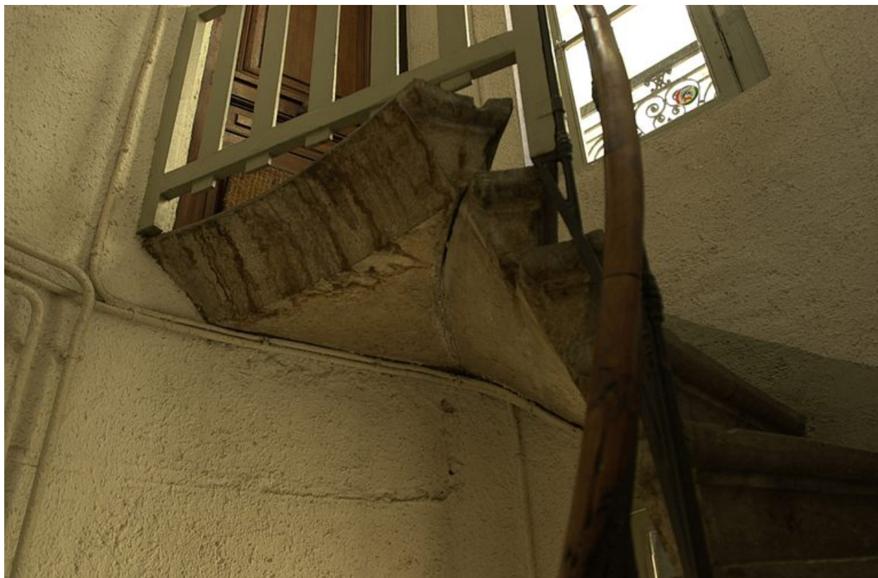
L'escalier : vue partielle de la dernière volée
