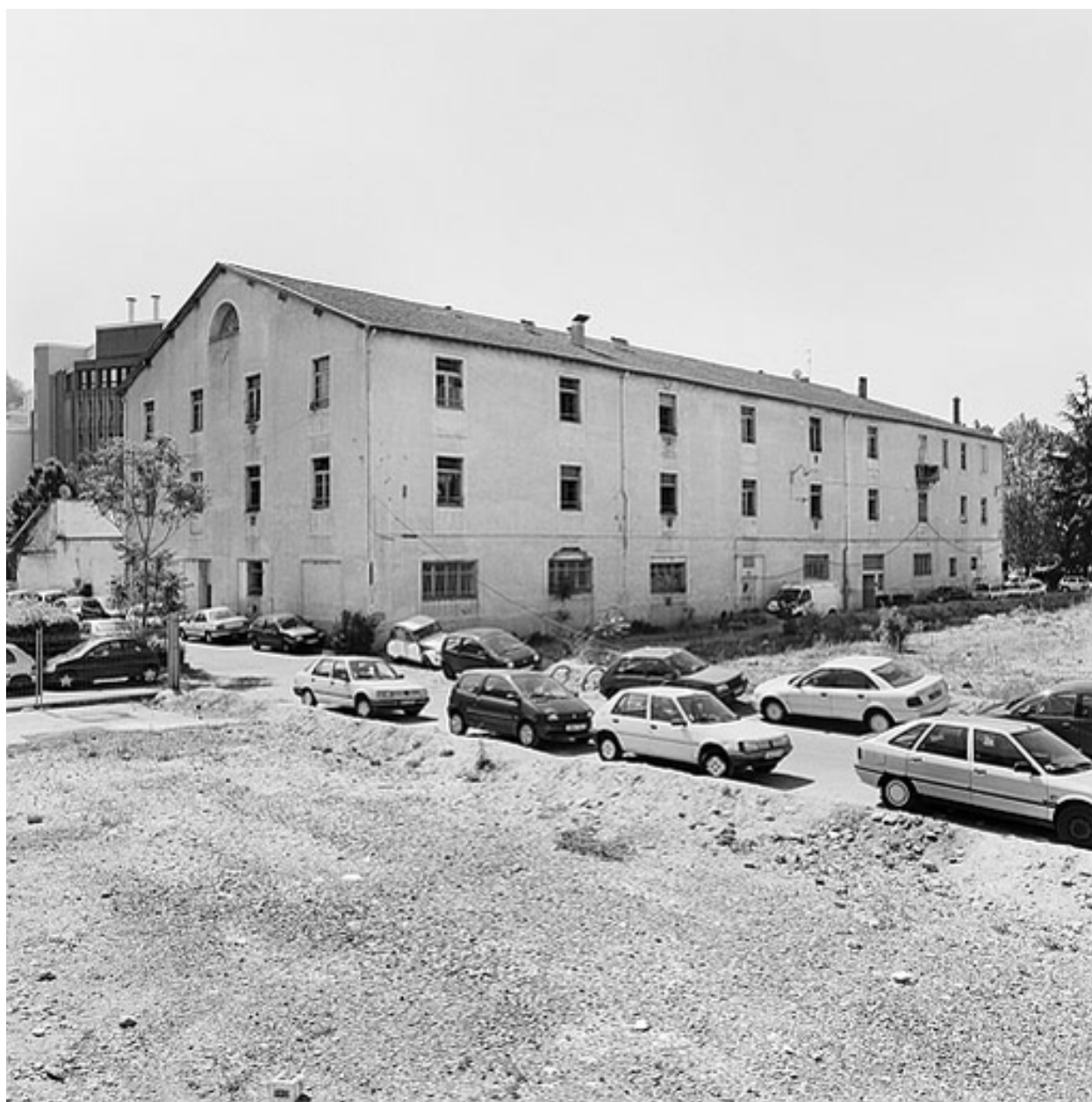
Vue d'ensemble ouest
