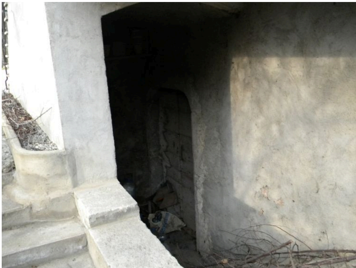
Entrée de la cave sous le perron d'entrée du logis.
