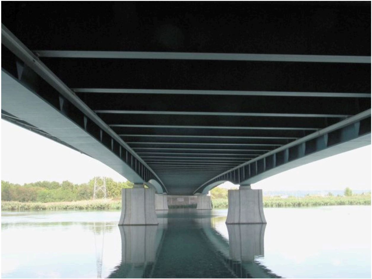
Vue générale, de dessous, tablier et piles (depuis la rive gauche)
