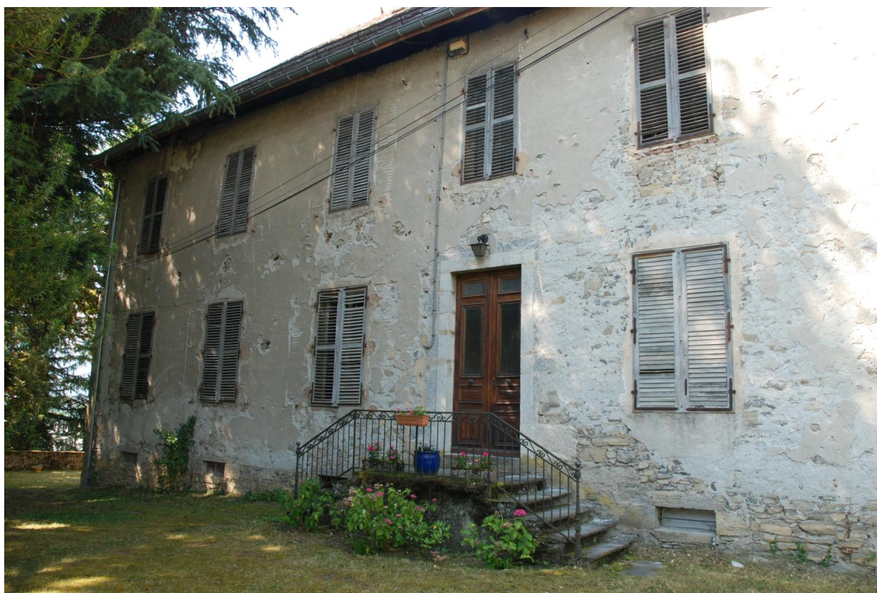
Vue de la façade antérieure.
