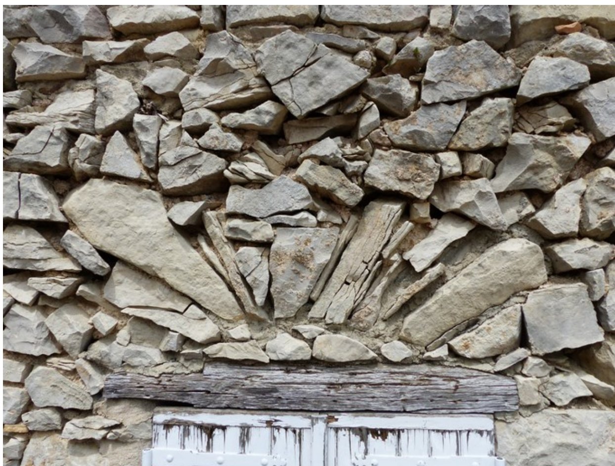
Arc de décharge au-dessus d'une baie, ferme au hameau de Valaury.
