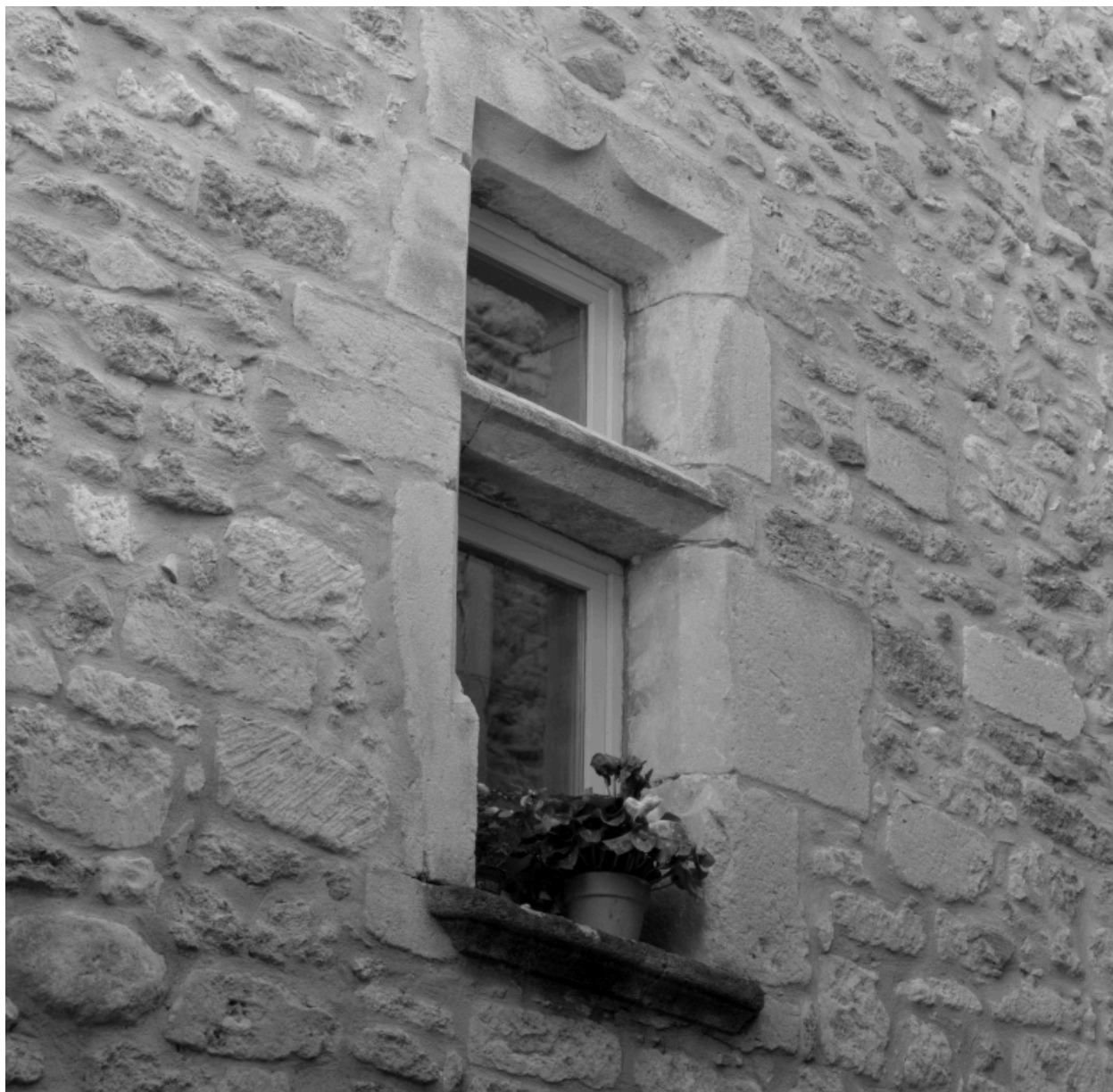
Rue Saint-Louis. Elévation sur un renforcement (D2 192) : fenêtre chanfreinée à traverse et à linteau taillé en accolade.
