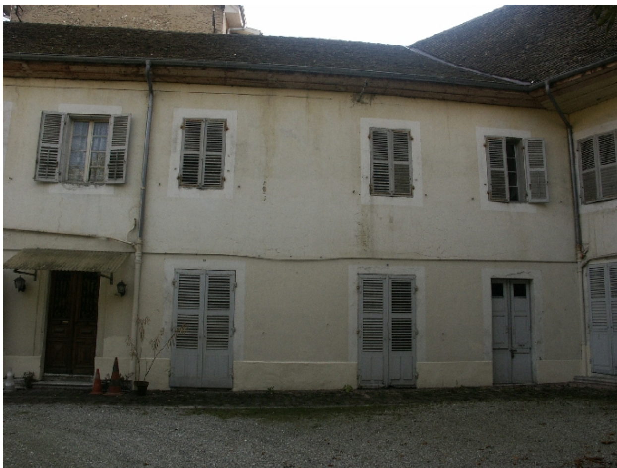
Façade sur cour : partie droite
