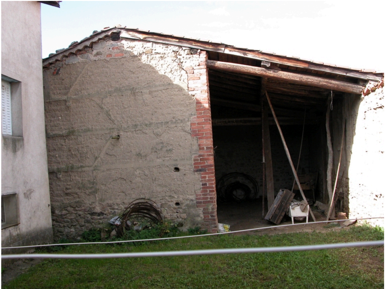
Vue de la remise-cuvage, depuis l'est.
