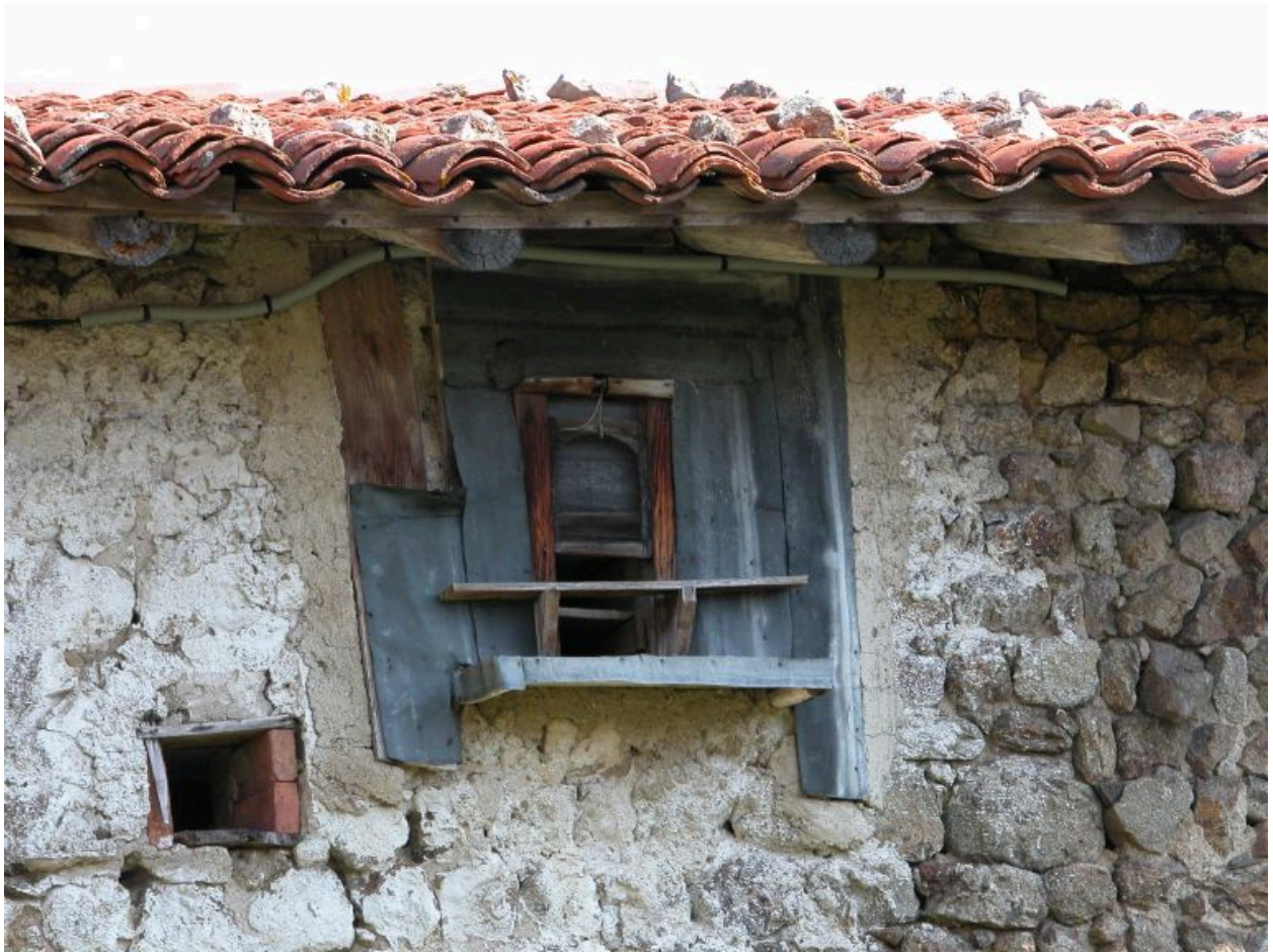
Détail du pigeonnier en façade.
