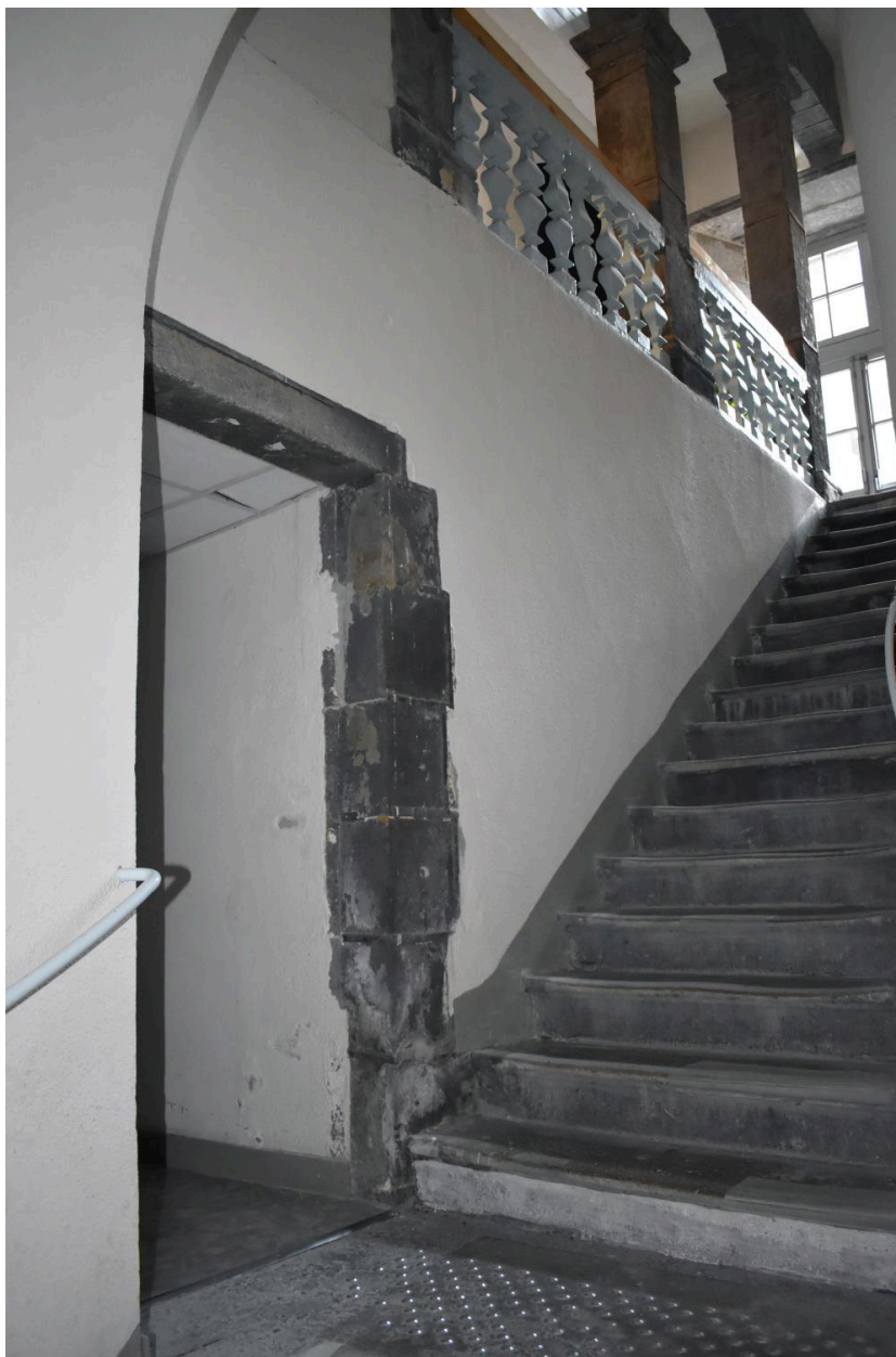
Escalier F : volée entre l'étage de soubassement et le rez-de-chaussée
