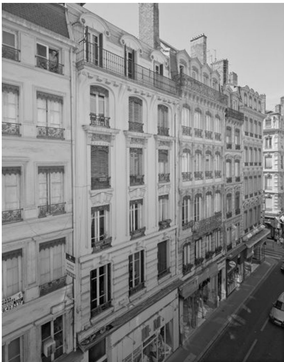
Façade, vue générale
