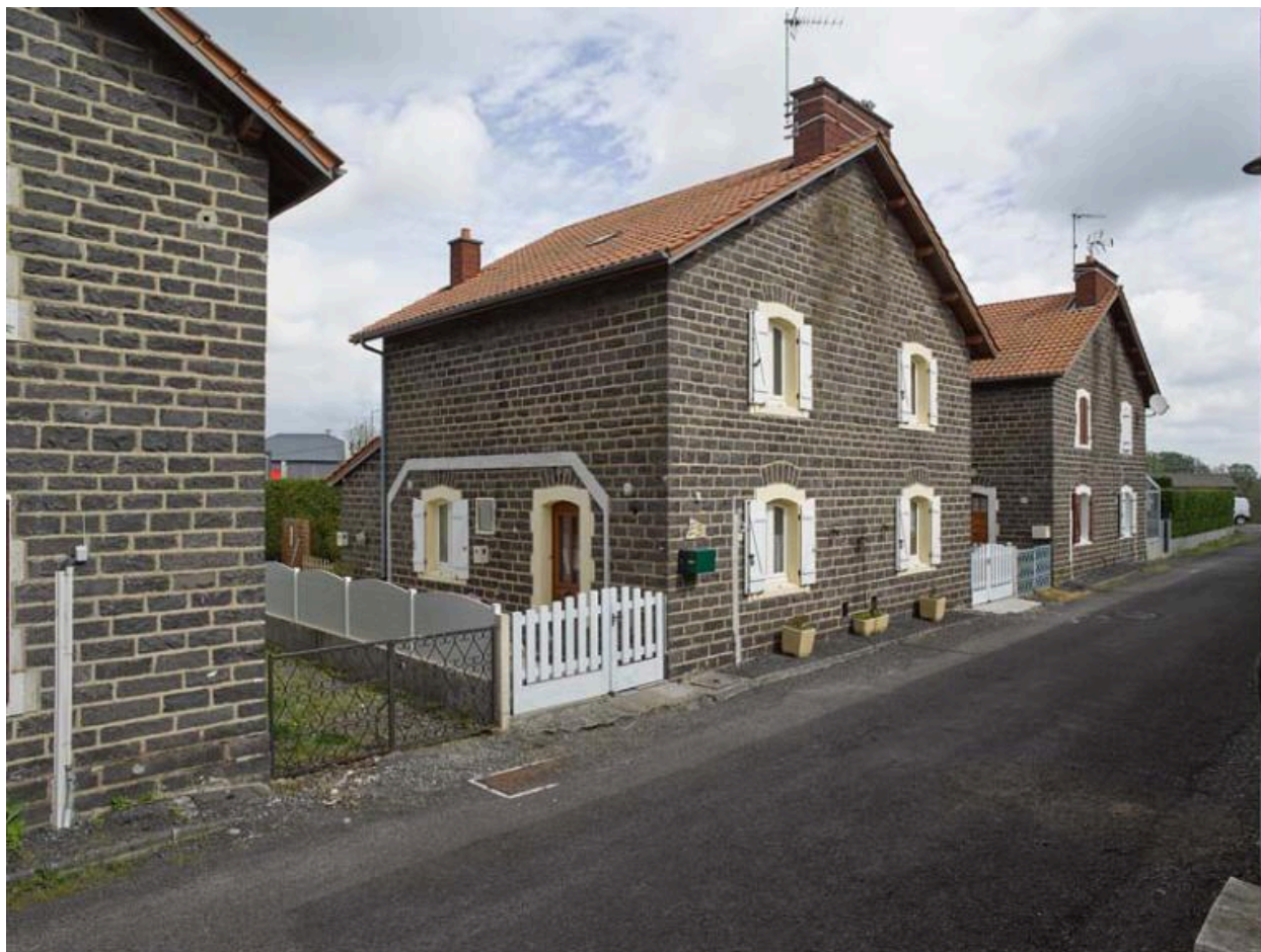
Maisons de cheminots dans le quartier de la gare de Laqueuille.
