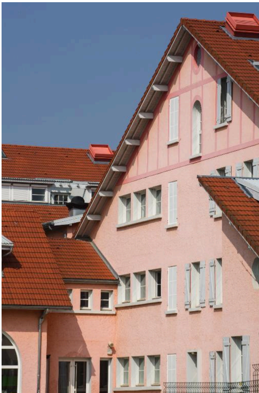
Bât. A : détail de la façade sud-ouest de l'aile est
