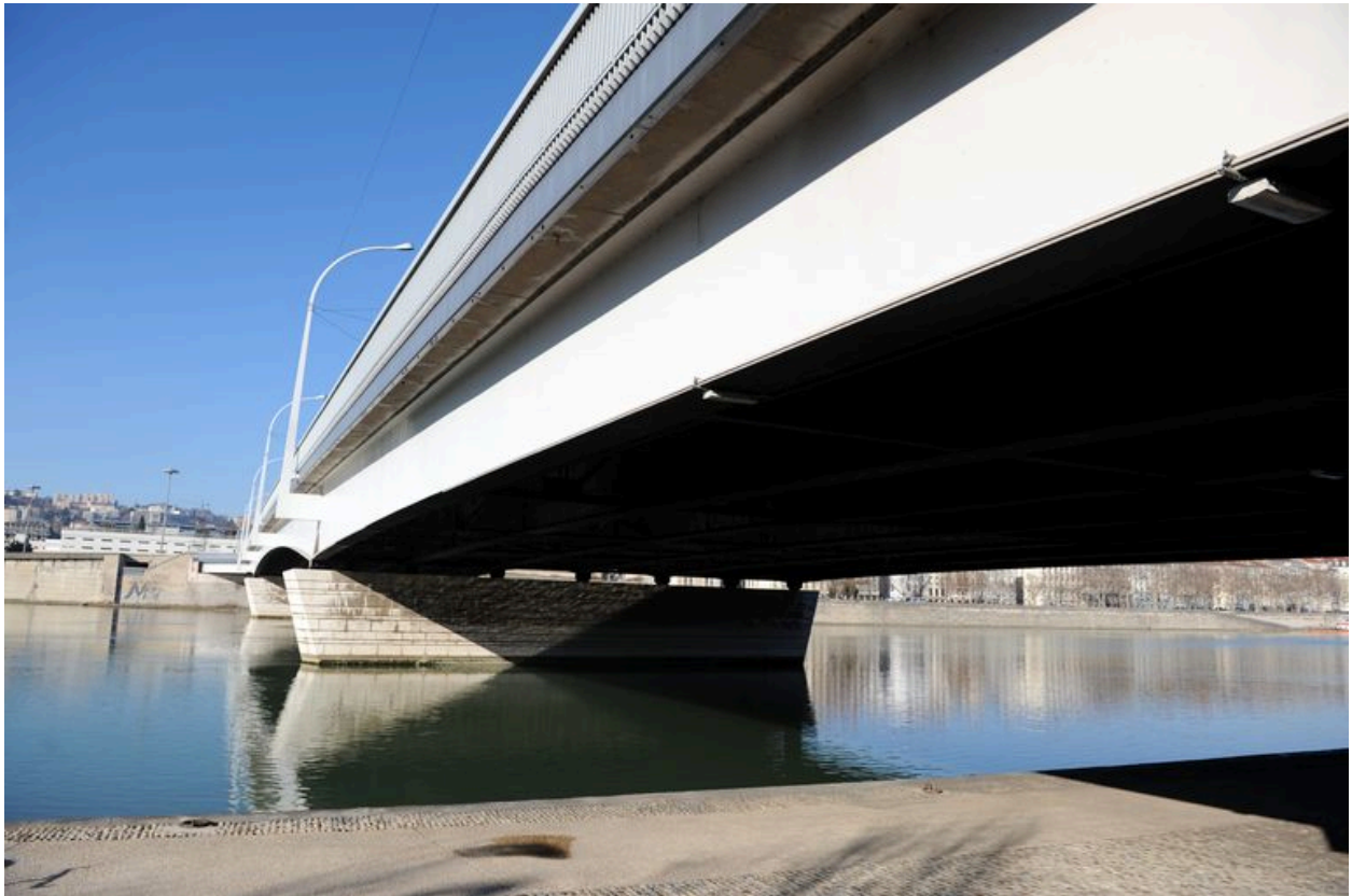
Vue générale, de côté et de dessous, face aval (depuis la rive gauche)
