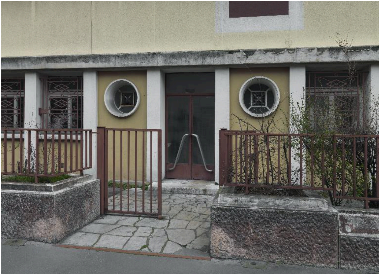
Élévation principale : entrée des cuisines
