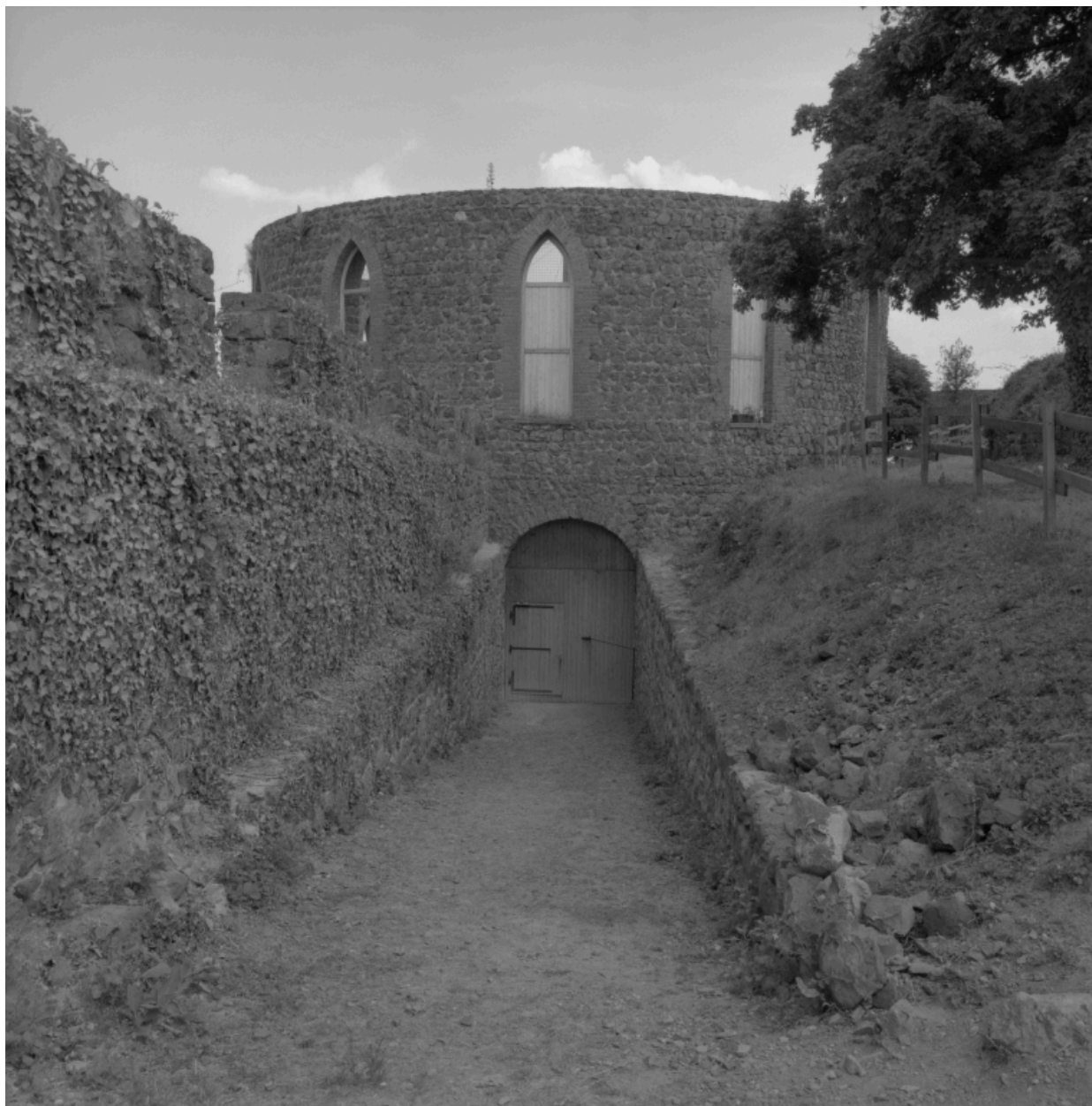
Vue extérieure de la tour nord-est de l'enceinte, depuis le nord.
