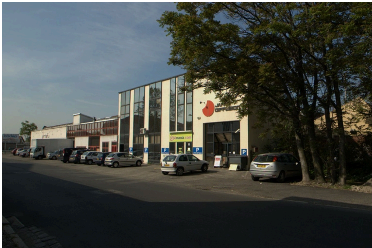
Vue d'ensemble nord-est
