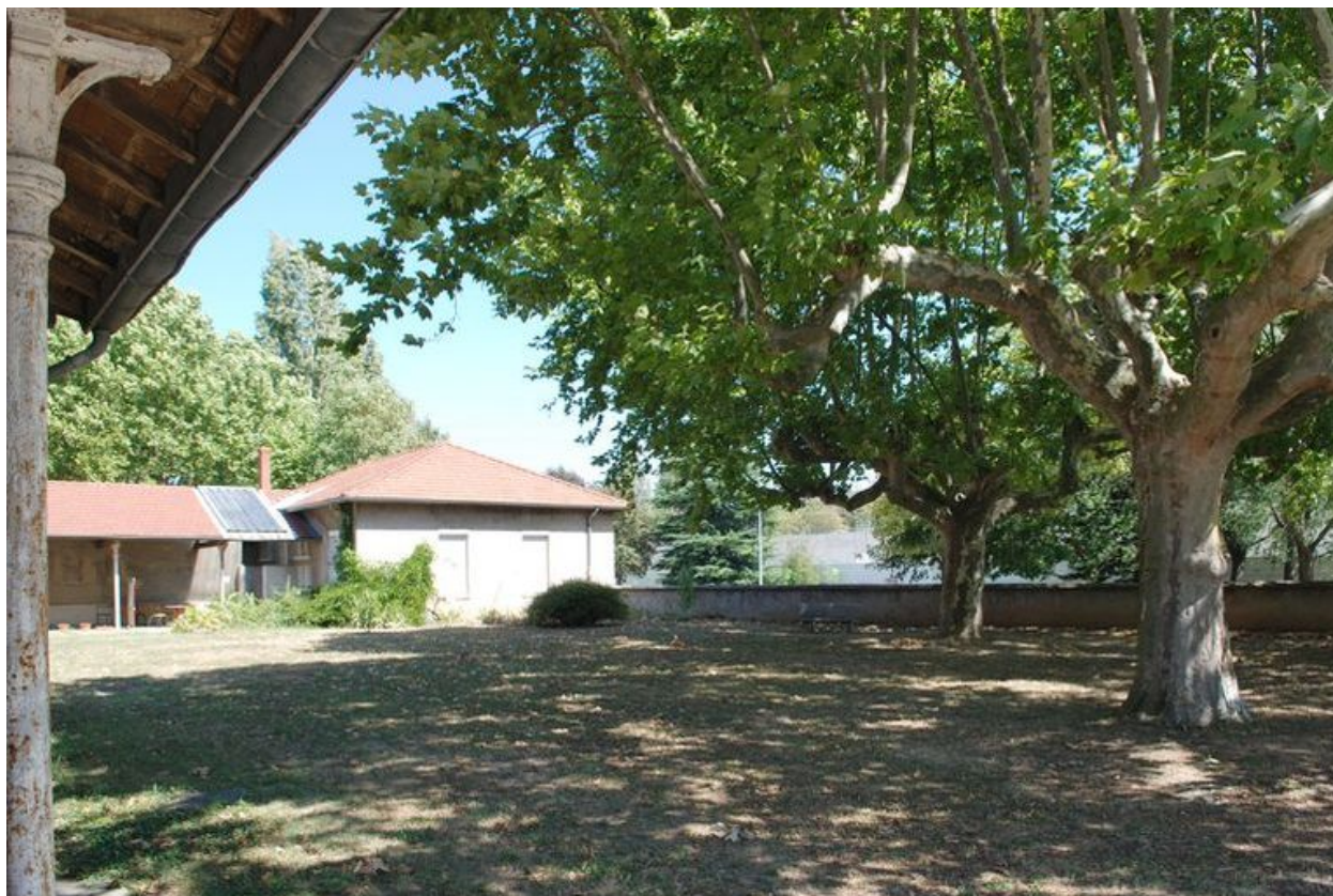
Bâtiment 456-457, façade postérieure (est) : l'ancienne buanderie remaniée
