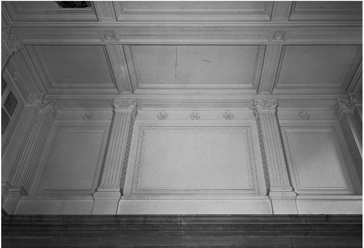
Ecole vétérinaire, vestibule des tribunes de l'amphithéâtre, au premier étage, deuxième niveau de l'élévation et plafond
