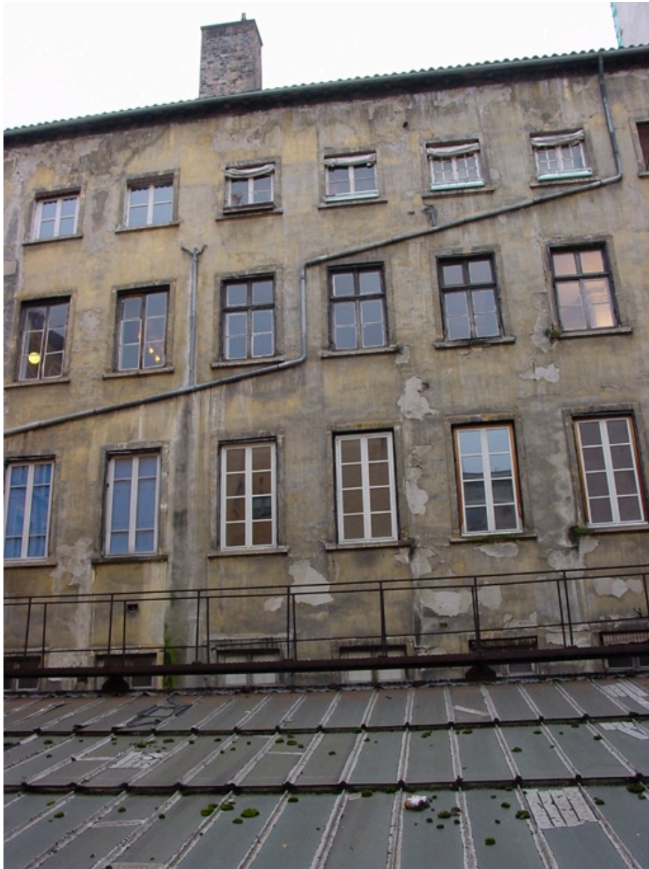
Vue de la verrière et de la façade arrière de l'immeuble
