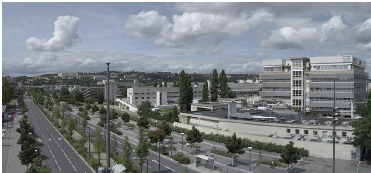
Vue d'ensemble sud-est
